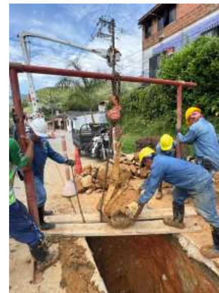
Mantenimiento y limpieza de alcantarillados
