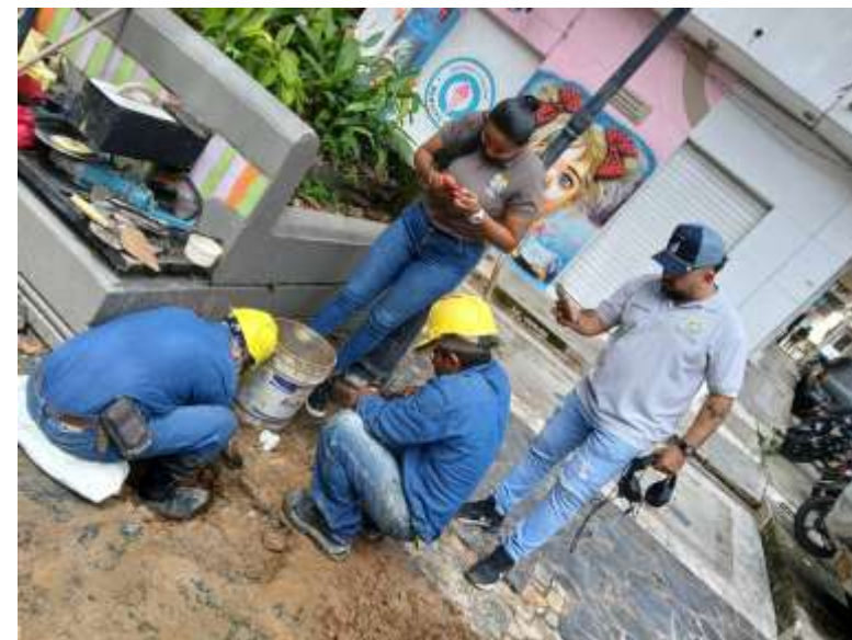
Arreglo de fugas de agua
