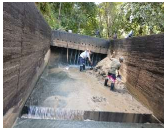
Mantenimiento bocatomas y desarenadores
