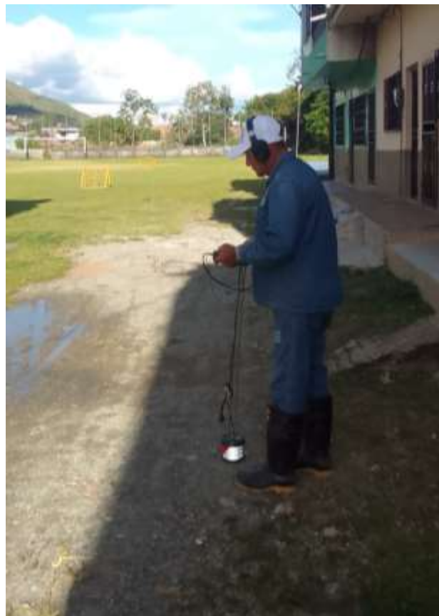
Detección de fugas
