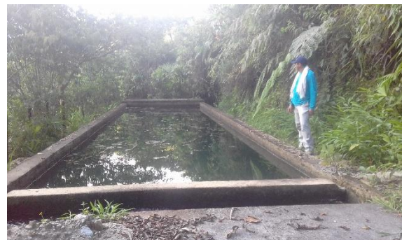
Desarenador del acueducto municipal.
