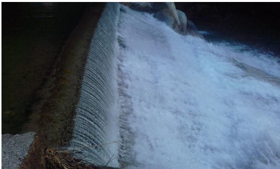
Fuente de abastecimiento del acueducto (Quebrada Santa Gertrudis).
