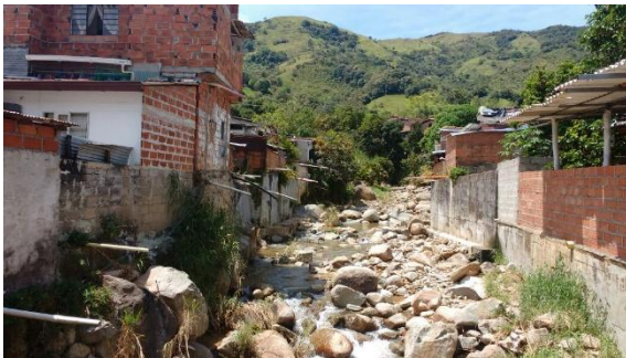
Viviendas ubicadas sobre la ronda hídrica de la Quebrada San Germán
