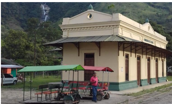
Estación del ferrocarril en la vereda El Limón.
