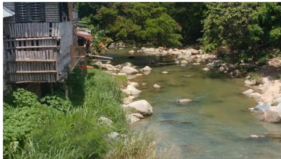
Río Nus. Obsérvense las construcciones sobre la ronda hídrica y los vertimientos.
