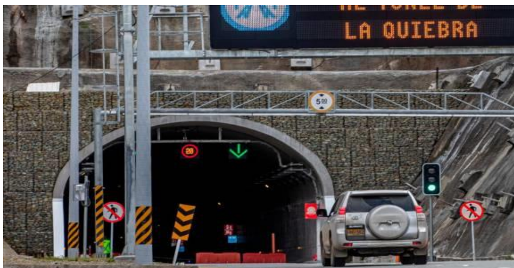
El Túnel de la Quebra, la Mega obra que integra a las comunidades del Nordeste y Magdalena Medio y otros Departamentos del País. 2023.
